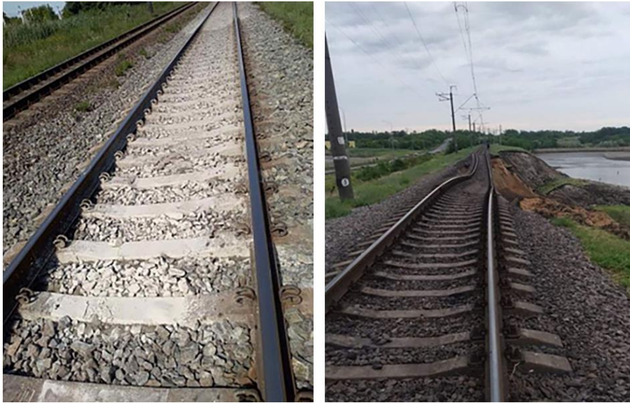
Рисунок 1. Дефектні місця земляного полотна: a – ділянка залізничної колії з вихлюпами; b – втрата стійкості укосу земляного полотна через розуцільнення ґрунтів
